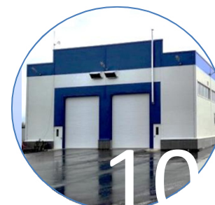
冷藏箱清洁和 清洗，拖拉机和拖车清洗
